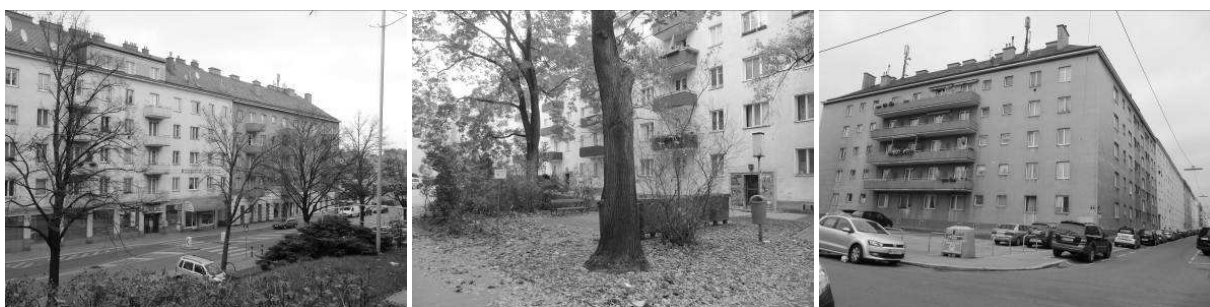
Fig. 2: Ansichten der Wohnhausanlage Krottenbachstraße 40; 42-46. Fotos: Andrea Weninger
