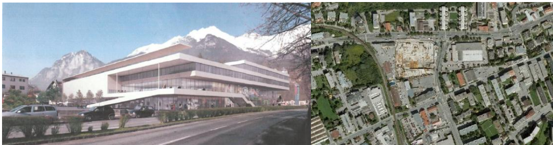
Abb. 1: Einkaufszentrum West und Bundesrealgymnasium in der Au, Bachlechnerstraße, Innsbruck von Arge Reitter - Eck-Reiter. Aktuelle Ansicht von Süden. Das Luftbild zeigt die stadträumliche Situation der Baustelle: im Kreuzungspunkt verschiedener baulicher Strukturen an einer stark befahrenen Kreuzung.
