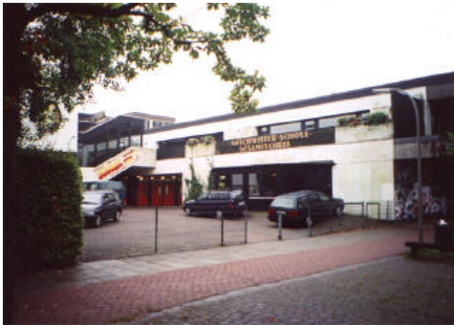
Abb.4: Eingangsbereich der Geschwister-Scholl-Schule vor dem Umbau
